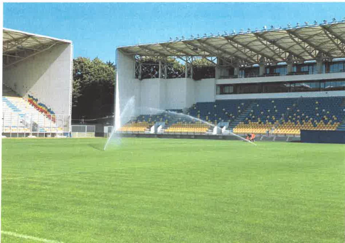
Foto 8 Jetul aspersoarelor de tip 2 (funcționare simultană).
